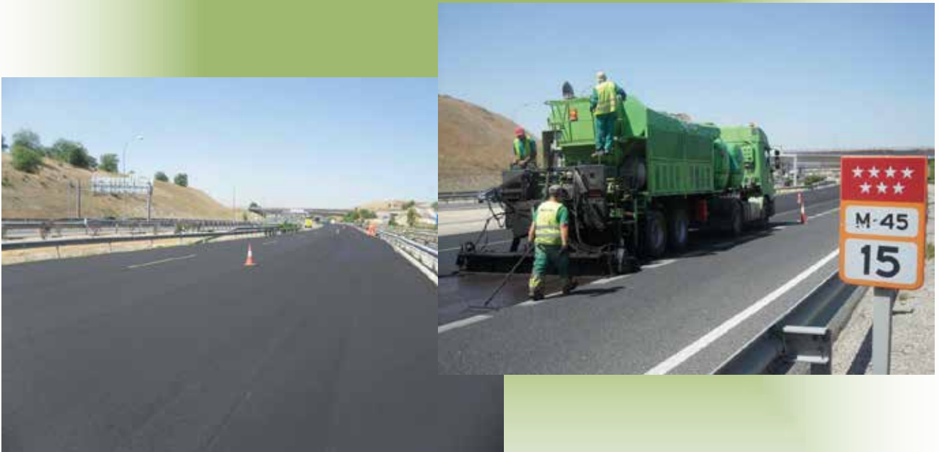
AUTOVIA M-45 Madrid
