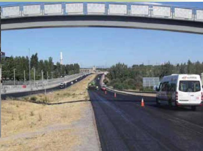
Extendido de Microaglomerado en frío en la carretera M-502, tramo: Aluche - Pozuelo de Alarcón (Madrid)
