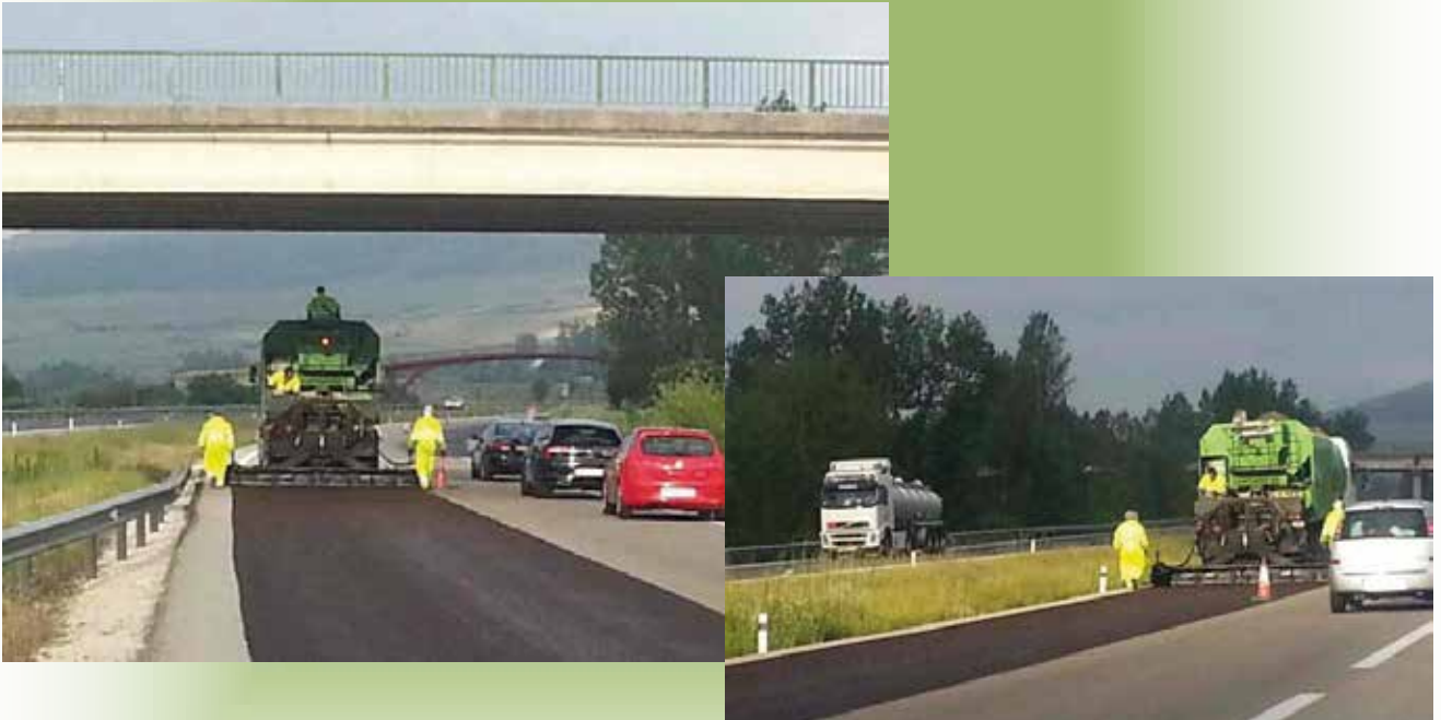
Trabajos de Microaglomerado en frío en la Autopista AP-1, Burgos - Armiñón
