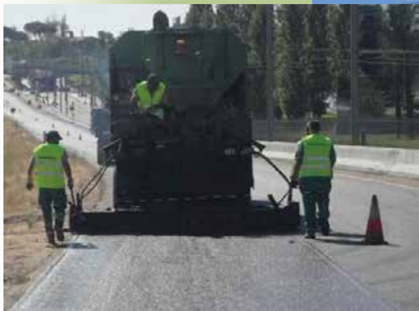
Extendido de Microaglomerado en frío en la carretera M-502, tramo: Aluche - Pozuelo de Alarcón (Madrid)
